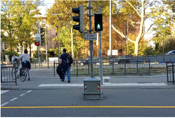
Abbildung 2: Provisorische bedarfsgesteuerte Lichtsignalanlage an der westlichen Seite der Haltestelle Mühlburger Tor
