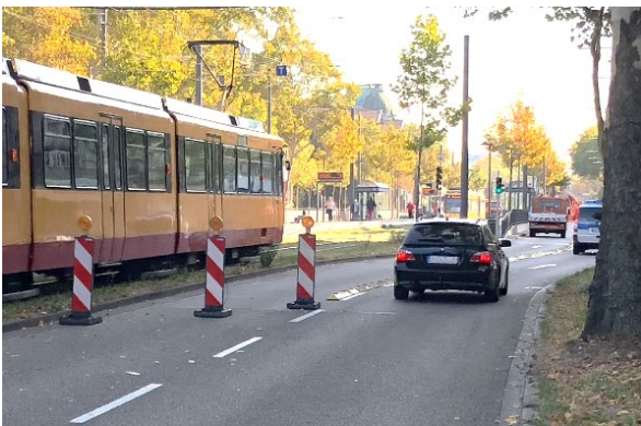
Abbildung 3: Reduzierung der Fahrbahn auf einen Fahrstreifen mit Baken (stadteinwärts)
